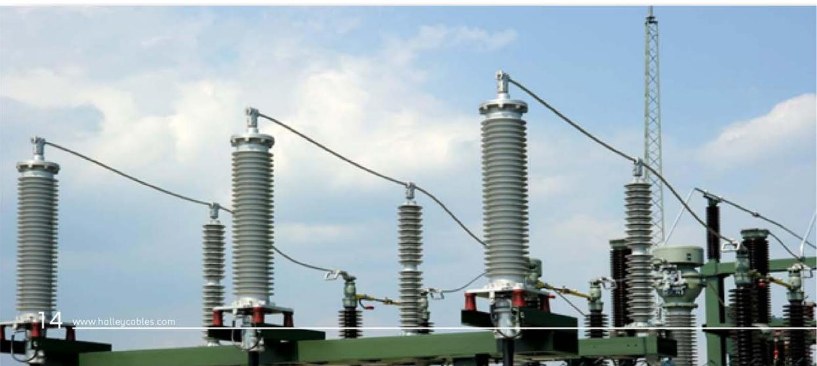
Terminalele exterioare sunt instalate având izolație din porțelan sau material compozit. Lungimea căii de conturare a izolației este specificată pentru a întruni cerințele aplicației respective. De obicei, sunt instalate pe o structură de susținere din oțel, folosindu-se post-izolatori unde este cazul; astfel se oferă izolarea necesară dintre placa de fundație a terminalului și structura de suport împământată pe durata testării învelișului.
